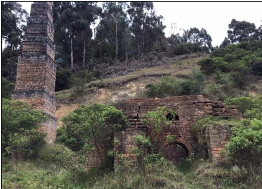
**Fotografía No. 4. Antigua Ladrillera Roa. Antiguo horno de cocción y chimenea deterioradas**
